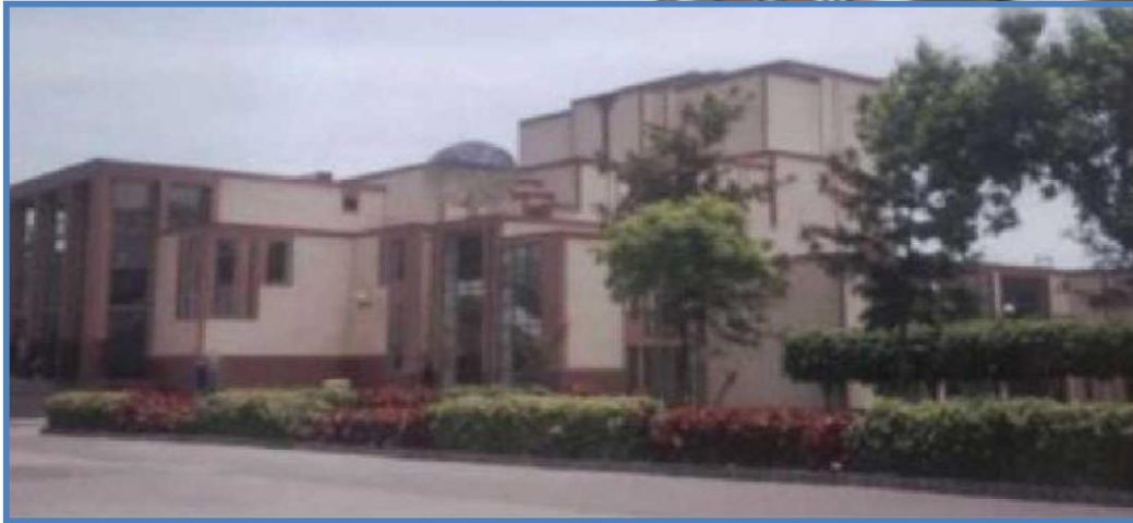
FOTO VISTA LATERAL HACIA EL CAMPUS
