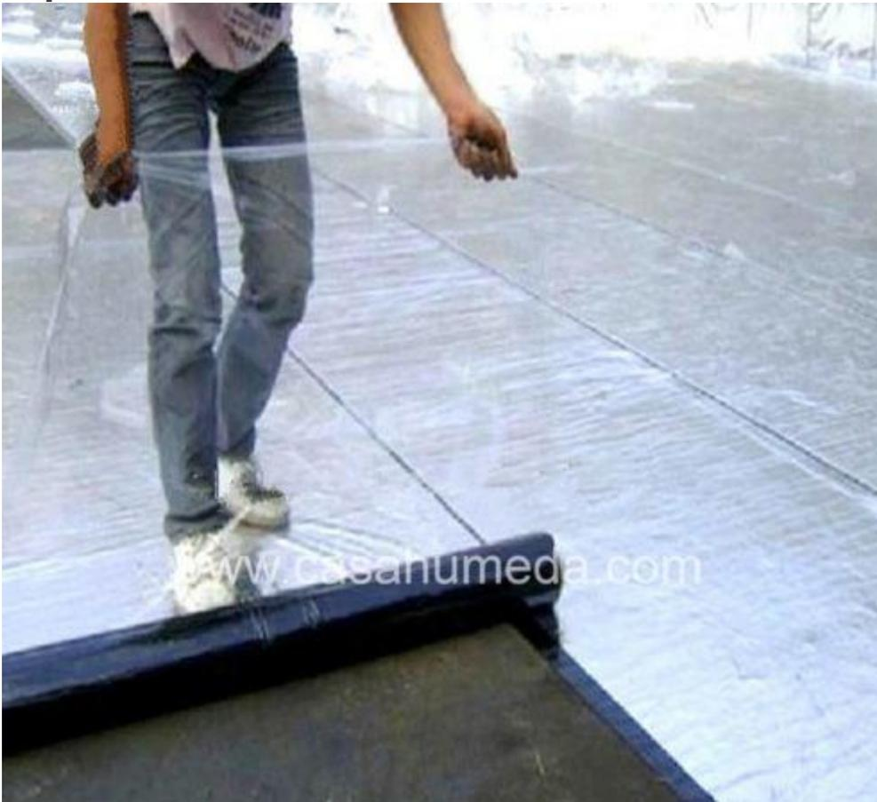
Algunas membranas se unen incluso fundiéndolas con una pistola de aire caliente y luego superponiéndolas sobre la lámina previamente colocada.
