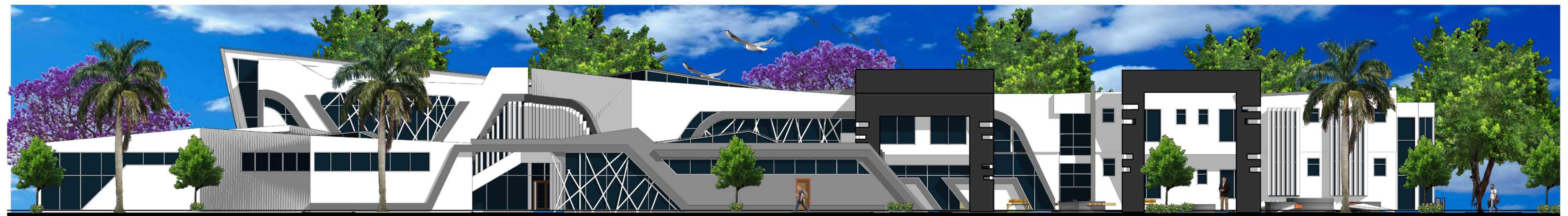
FACHADA POSTERIOR BLOQUE ADMINISTRATIVO
