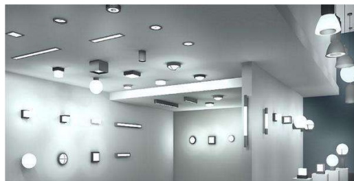
Figura N° 17: Luminarias colgadas y empotradas en piso y pared.
