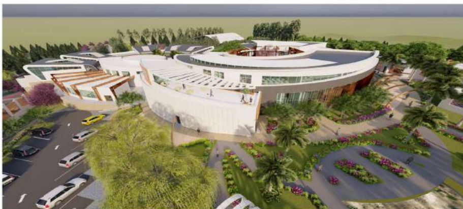
VISTA DEL ESTACIONAMIENTO NUMERO DE LAMINA
