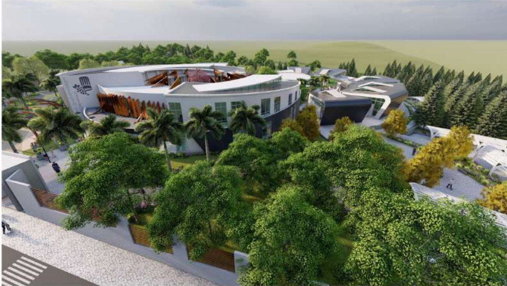
VISTA EXTEIOR DESDE LADO OESTE
