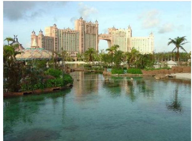
VISTA GENERAL DE CENTRO VACACIONAL
