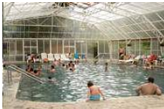
PISCINA CON PANELES DE RETENCIÓN DE CALOR
