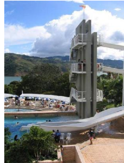
GRADAS DE CONCRETO PARA LAS ACTIVIDADES DE LA PISCINA
