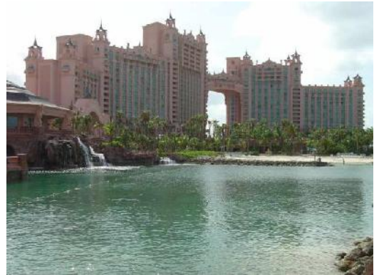
VISTA GENERAL DE LA EDIFICACION
