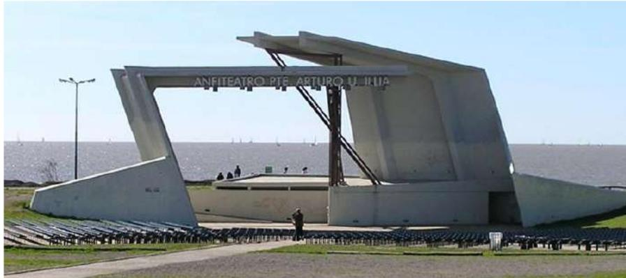
**Tecnología.-** El sistema tecnológico empleado para la construcción fue el hormigón armado para lograr los voladizos que funcionan como cubierta, sostenidos por un armazón de estructura metálica vista; que funciona como puntales de soporte.
