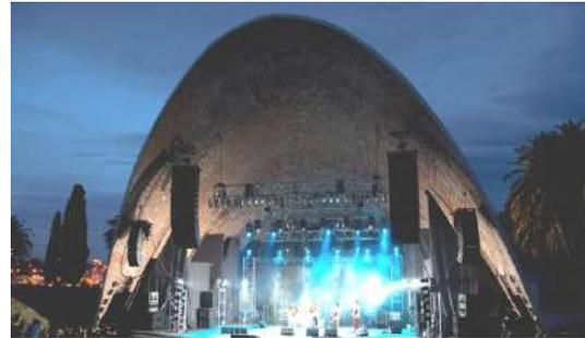
**Tecnología.-** La construcción de un techo de ladrillo sobre el escenario, es una singular obra del ingeniero Eladio Dieste basada en una curva en forma de catenaria y armada con ladrillo; cuenta con un sistema de 196 insertos metálicos que soportan cargas de 500 y 250 kgs. para colgar equipamientos y escenografías; la disposición de los mismos hace estructuralmente se sostenga; trabaje a presión y no deforme la
