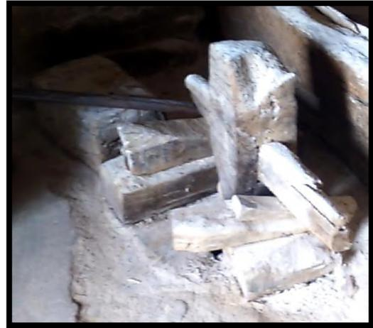
Como se puede ver en la imagen simplemente es un listón ubicado de manera vertical atravesado por uno pequeño que sirve de apoyo para elevar el mismo con un movimiento de palanca ayudado por una barra metálica
