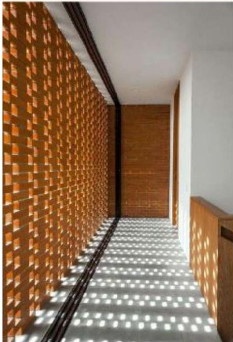
La trama de ladrillo gambote junto con las ventanas tipo parasoles, controla el exceso de luz y calor en las fachadas distribuyendo en calor entre los ladrillos así logrando un confort de temperatura en estos espacios.
