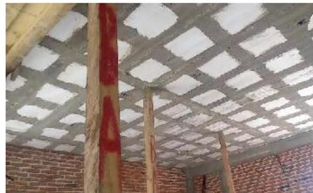
*Ilustración 48. losa casetonada*
