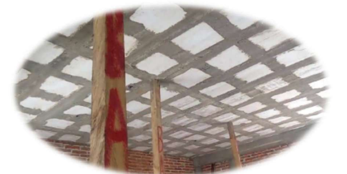
LOSA ALIVIANADA CON CASETONES DE PLASTOFOR
