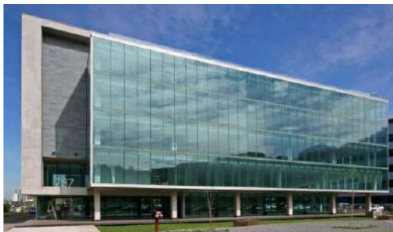
Figura 106.muro cortina
