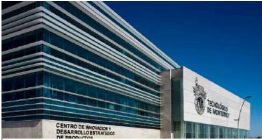
Figura 12. Fachadas (Instituto Monterrey)
