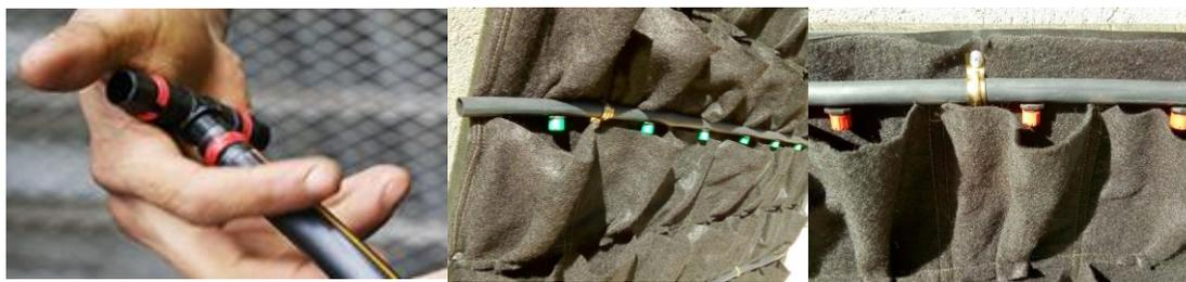
Imagen 3.34: Unión de las Tés a los tubos colocado de los goteros perforación de los goteros
