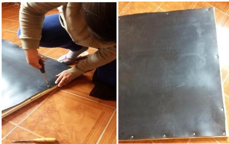
**Imagen 3.29:** colocado de la capa impermeabilizante a la estructura
