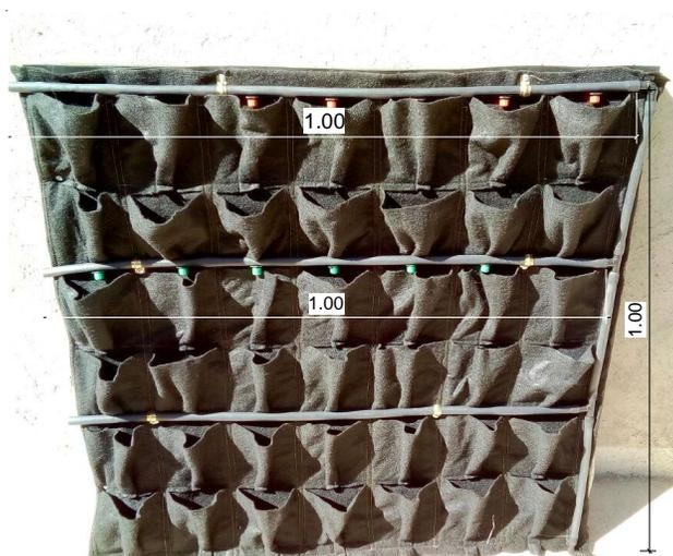
Imagen 3.33: Detalle de las dimensiones de la instalación de tubos para riego
