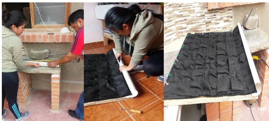
Imagen 4.36: Cortado y colocado del canal recolector de agua
