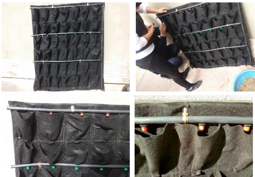
Armado de las mangueras por goteo
