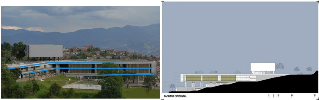
Fig. N°19 Analisis de Fachadas de colegio Santo Domingo Savio
