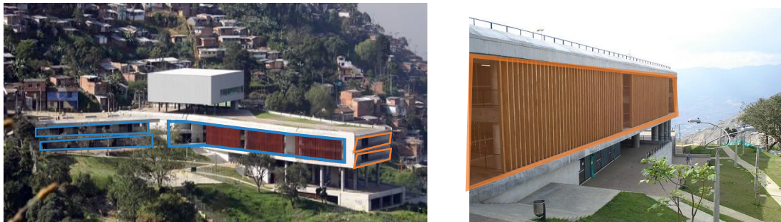
Fig. N°19 Analisis de Fachadas de colegio Santo Domingo Savio
