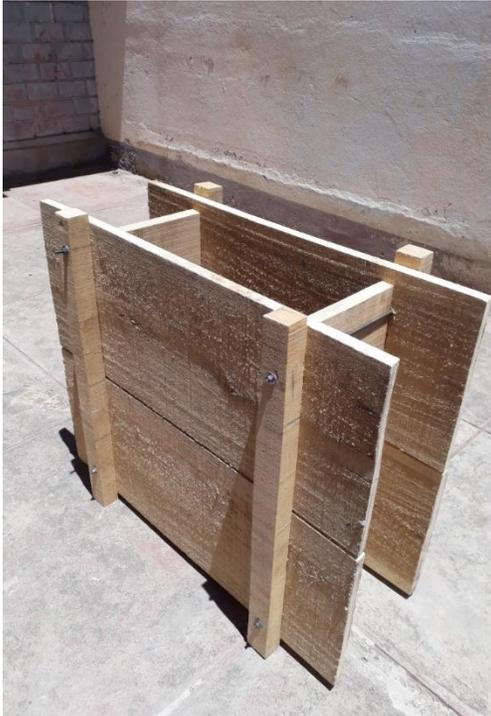
Figura 7.50 Encofrado de Madera
