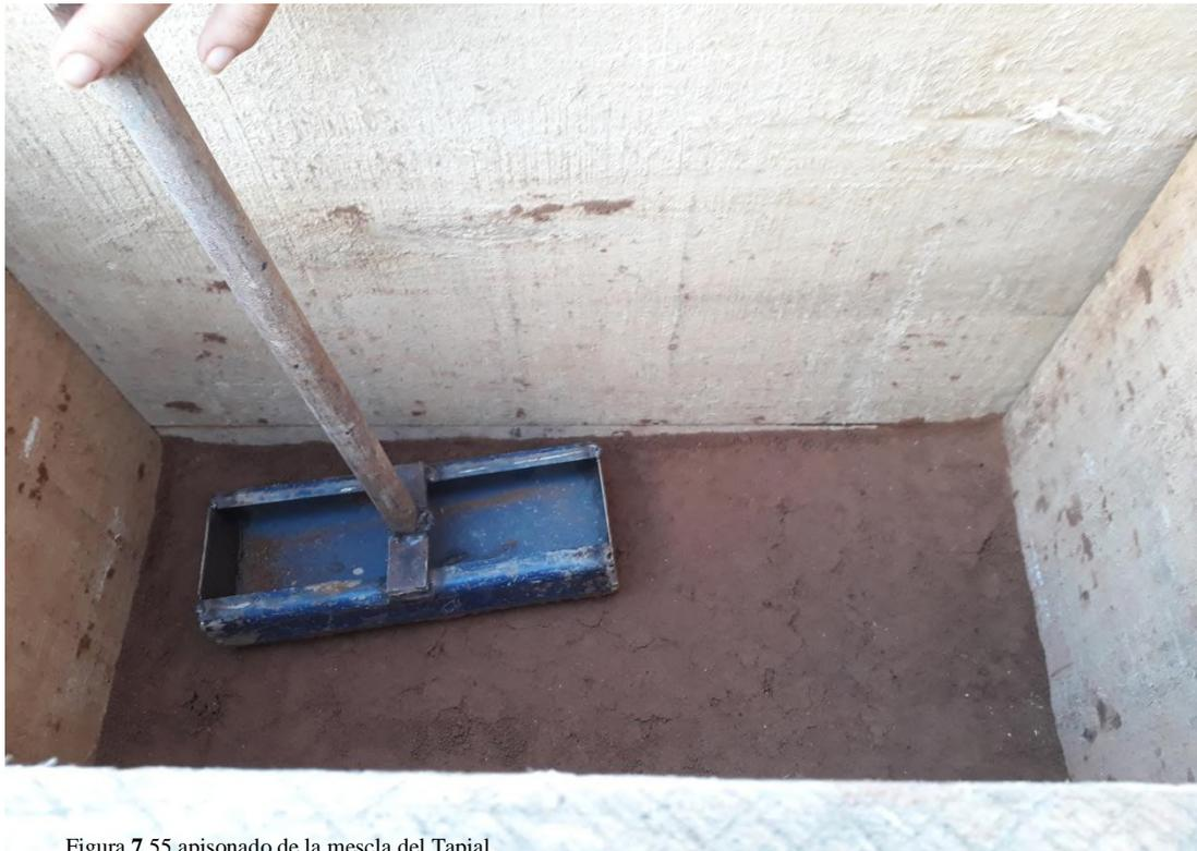
Figura 7.55 apisonado de la mezcla del Tapial.
