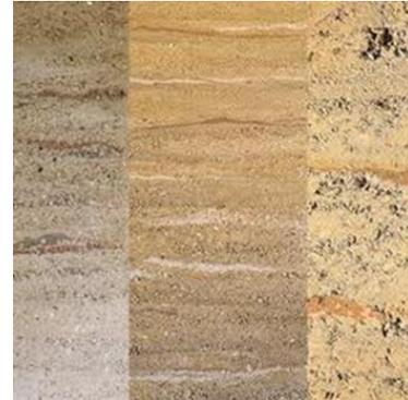
El tapial es básicamente está compuesta de tierra, cal y un relleno fraguada en un encofrado, es un elemento estructural que se lo realiza en situ.
