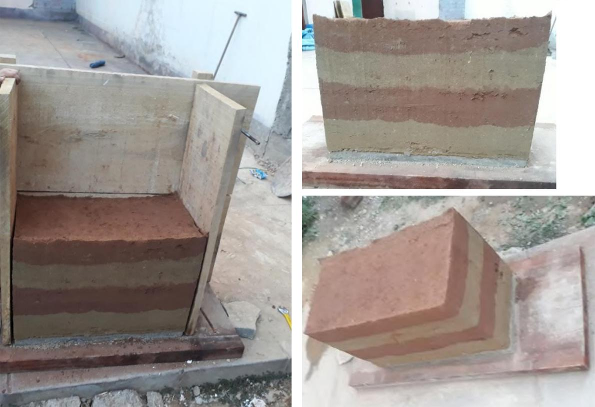
Figura 7.56 desmontaje del encofrado del Tapial.
