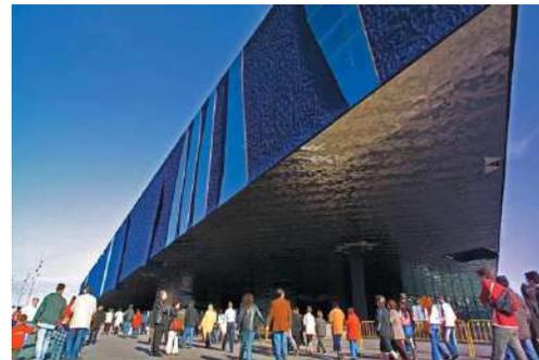
Visto desde el cielo, el edificio es un perfecto triángulo equilátero de 180 metros de lado suspendido sobre pilares. Pero su aspecto regular cambia cuando se ve el corte, la construcción alcanza unos 25 metros desde el piso y juega con las alturas en su interior, bajando un nivel con el auditorio abriendo huecos para ganar espacios públicos más allá del foyer.
