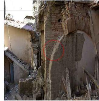
Las paredes de adobe se encuentran lavadas por las lluvias y factores climaticos que afectan todo el inmueble por ausencia de una cubierta.
