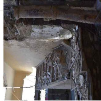
Gran parte de las escaleras cayo durante el colapso de la planta alta y la cubierta. La parte que aun se conserva esta muy deteriorada, la madera se encuentra en mal estado al igual que el cerámico que se observa en los primeros peldaños de la misma.
