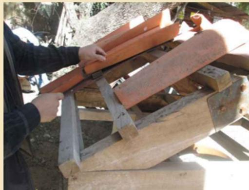
**Cubierta:** Se utilizara la técnica de la doble cubierta.
