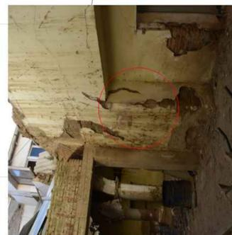
Se observa fisuras y desprendimiento del revoque en la pared, no existe cubierta y ausencia total de mantenimiento.
