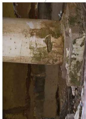
Existe desprendimiento de las molduras de los pilares, exceso de humedad.
