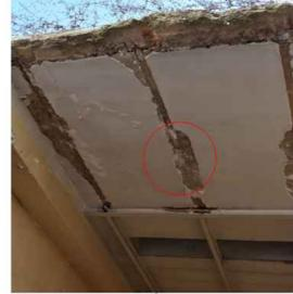
Desprendimiento de cielo falso, deformación en la parte superior del muro y crecimiento de vegetación.
