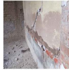
Abombamiento del muro y desprendimiento del revoque.
