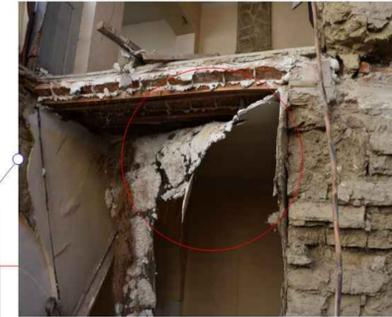
Desprendimiento del cielo falso por exceso de humedad.
