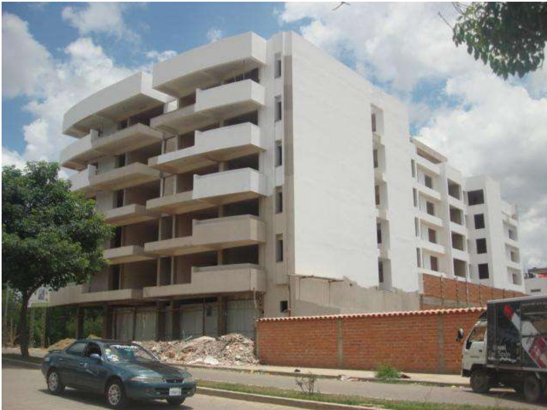
Este edificio se caracteriza por usar un sistema constructivo de pórticos de H°A°, para el cerramiento ladrillo y la cubierta y entrepisos de loza alivianada (viguetas pretensadas).
