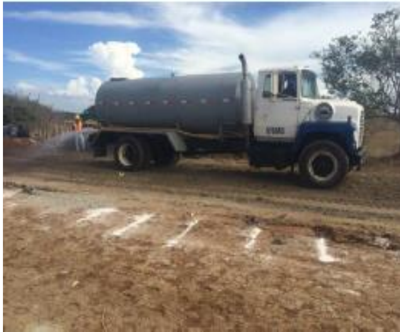
Figura 18 Aplicación del agua
