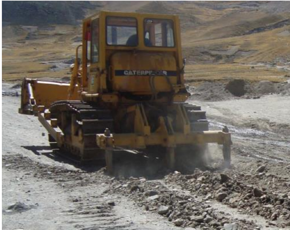
Figura 15 Escarificado del suelo
