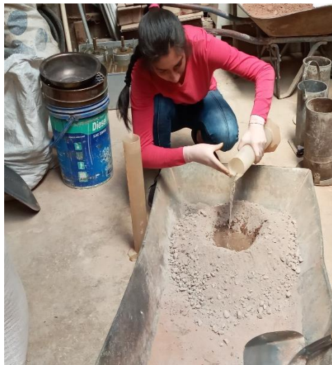
Figura 41 Adición del agua a la mezcla
