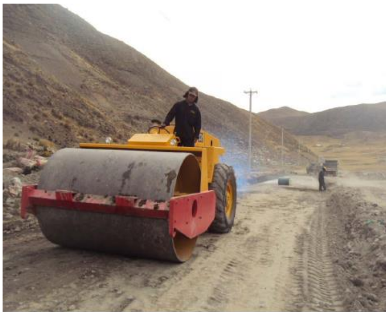
Figura 23 Proceso de Compactación
