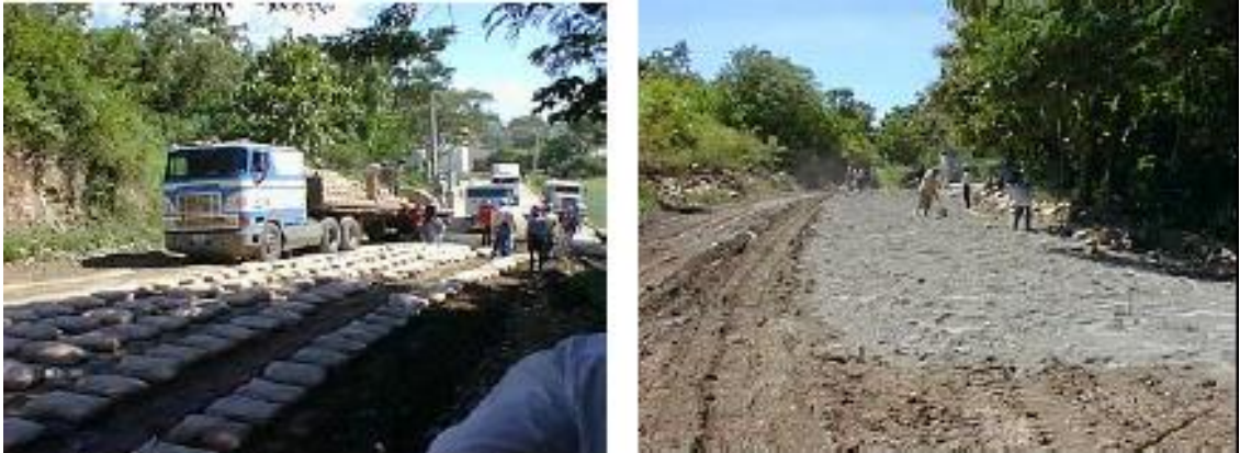
Figura 16 Colocado y la distribución del cemento
