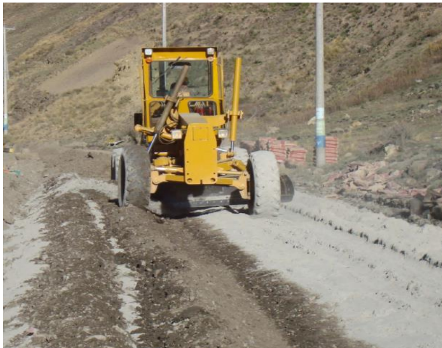
Figura 17 Mezclado del suelo con el cemento
