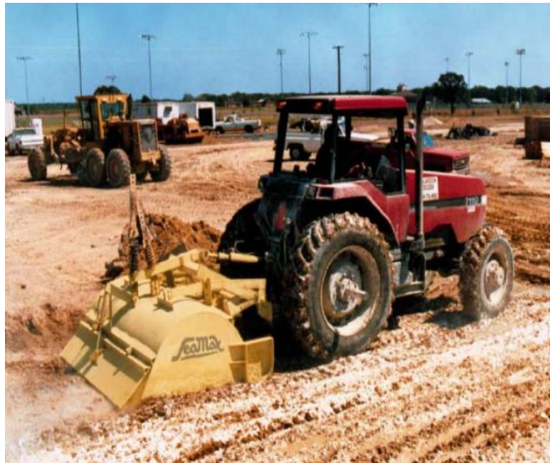
Figura 19 Pulvimezclador jalada por un tractor
