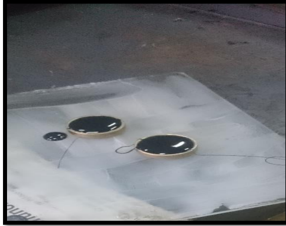
Figura C.16. Colocado del cemento asfáltico en los anillos
