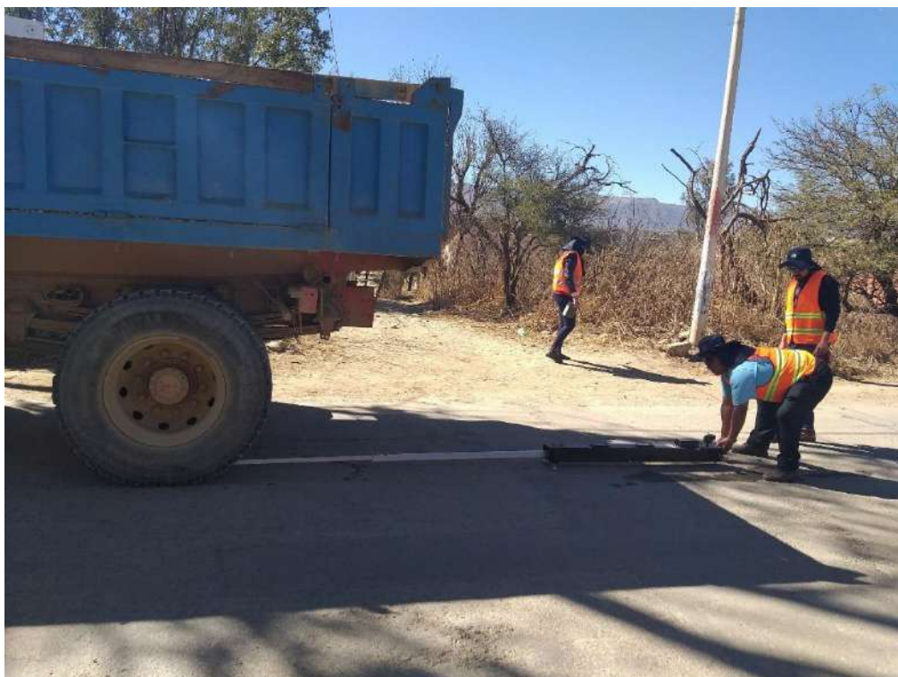
Procedimiento de ensayo de la viga con técnicos de laboratorio
