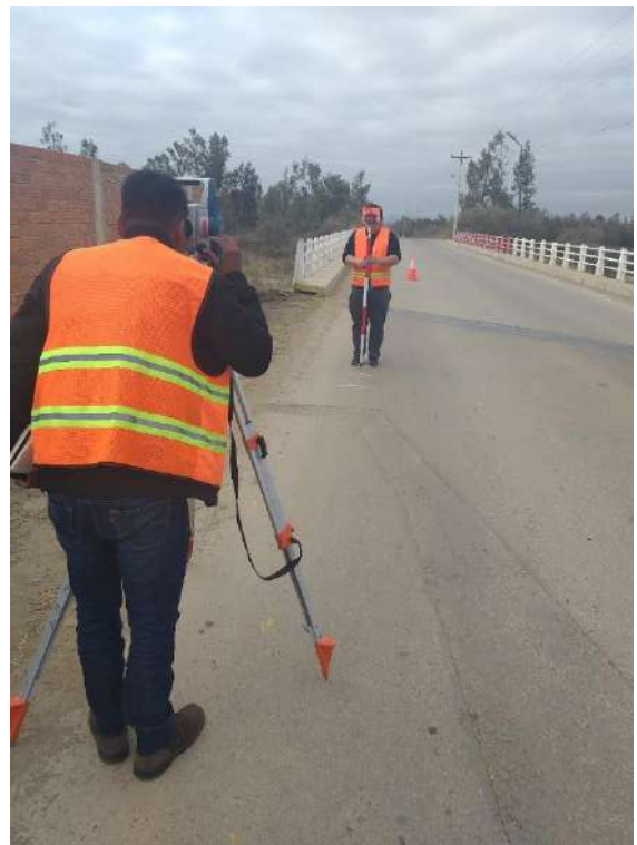
Procedimiento del ensayo del IRI con estación total con apoyo técnico en topografía
