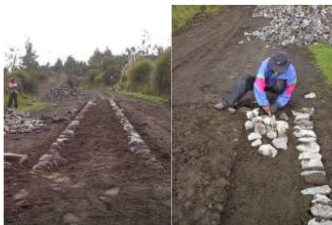
Imagen 2.3:4 Colocación de Maestras o cordones maestros y empedrado
