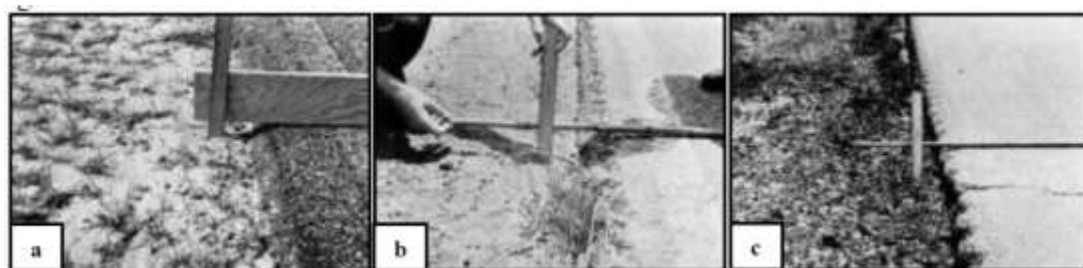
Imagen 2.9:9 Desnivel carril - berma de nivel de severidad bajo (a), medio (b) y alto (c).
