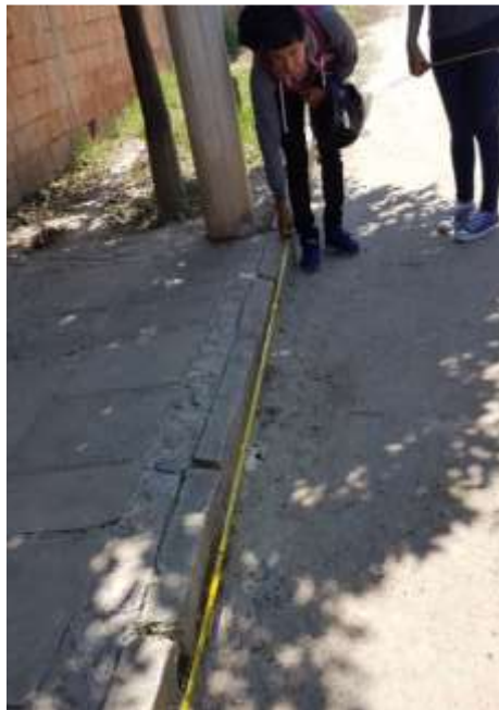
Fisuras de borde
