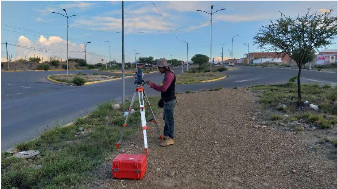
Final del tramo, último cambio de estación
