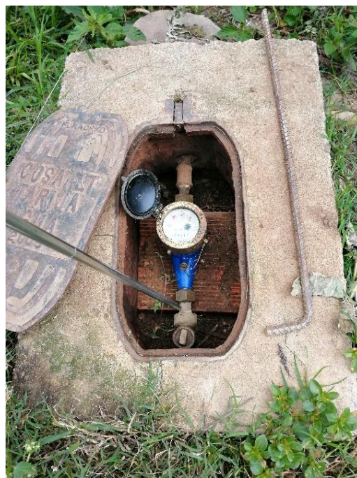
Fotografía N° 6 Varilla acústica para detección de fugas
