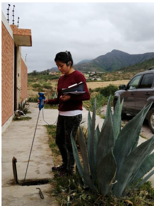
Fotografía N° 5 Búsqueda de fugas de agua
