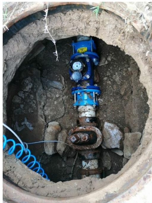
Fotografía N° 4 Verificación del funcionamiento
