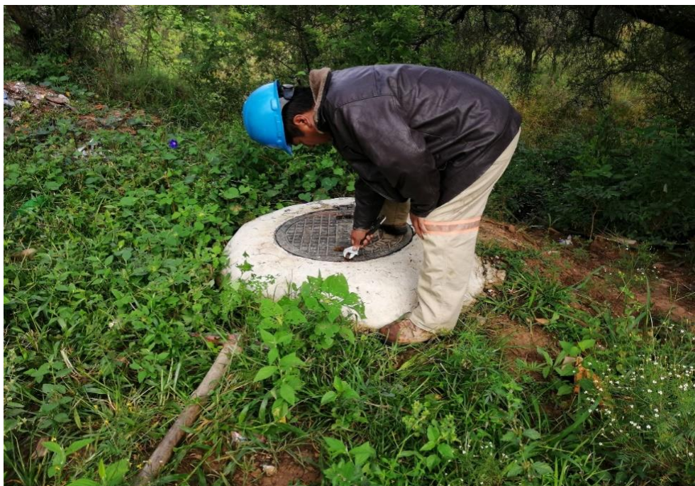
Fotografía N° 1 Destapando la cámara del macromedidor
