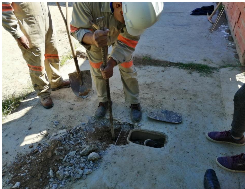
Fotografía N° 5 Proceso de excavación para reparar la fuga
