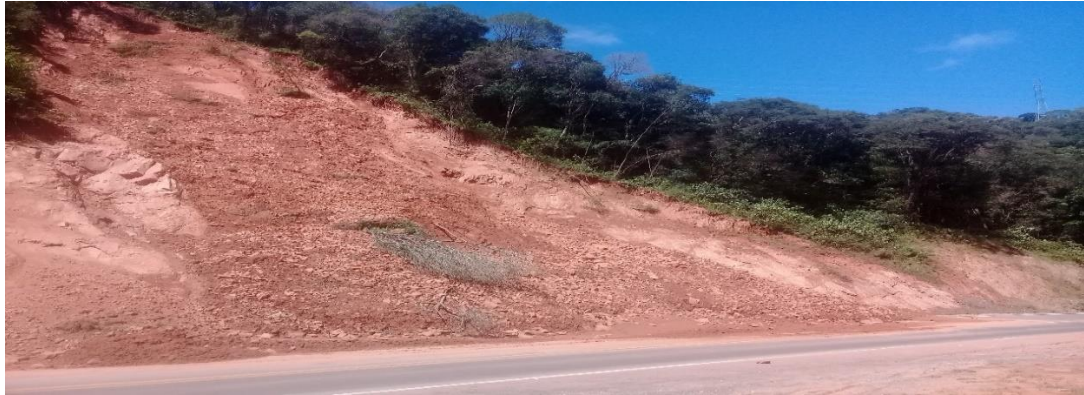
Figura: Vista del talud N° 1
