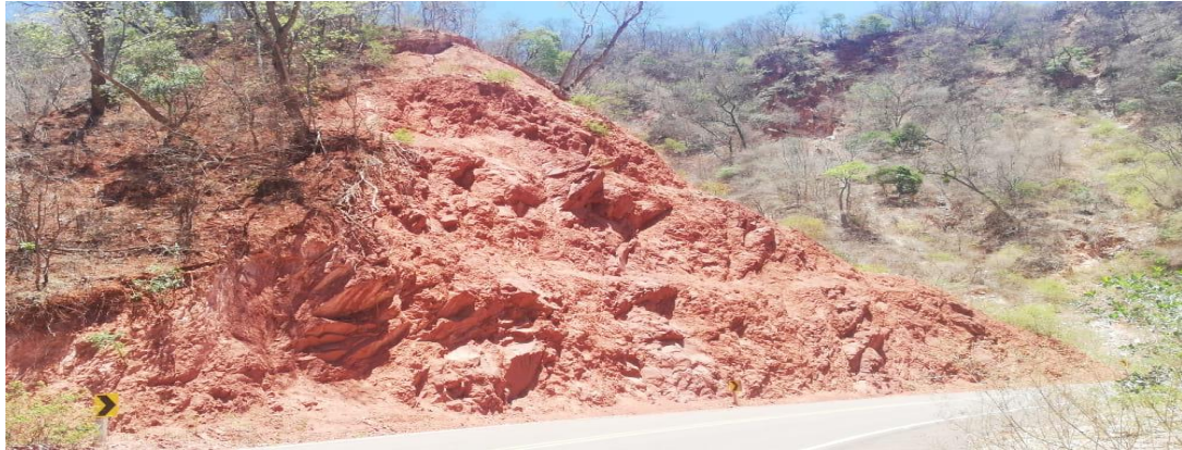
Figura: Vista del talud N° 4
