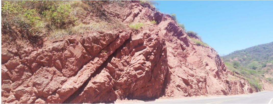
Figura: Vista del talud N° 7
