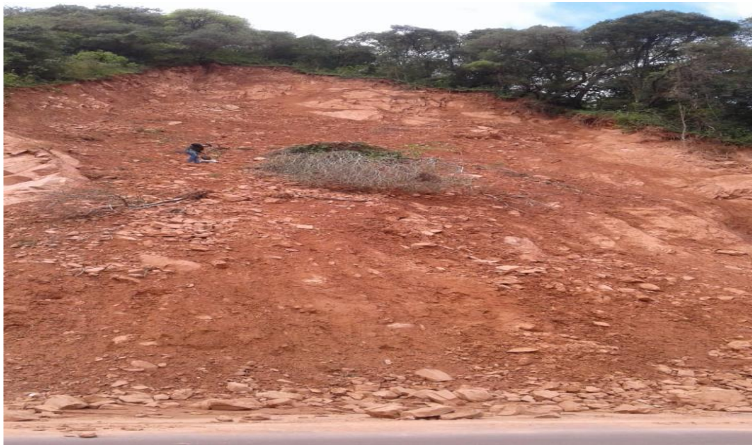
Figura: Extracción de suelo de la parte del cuerpo del talud
