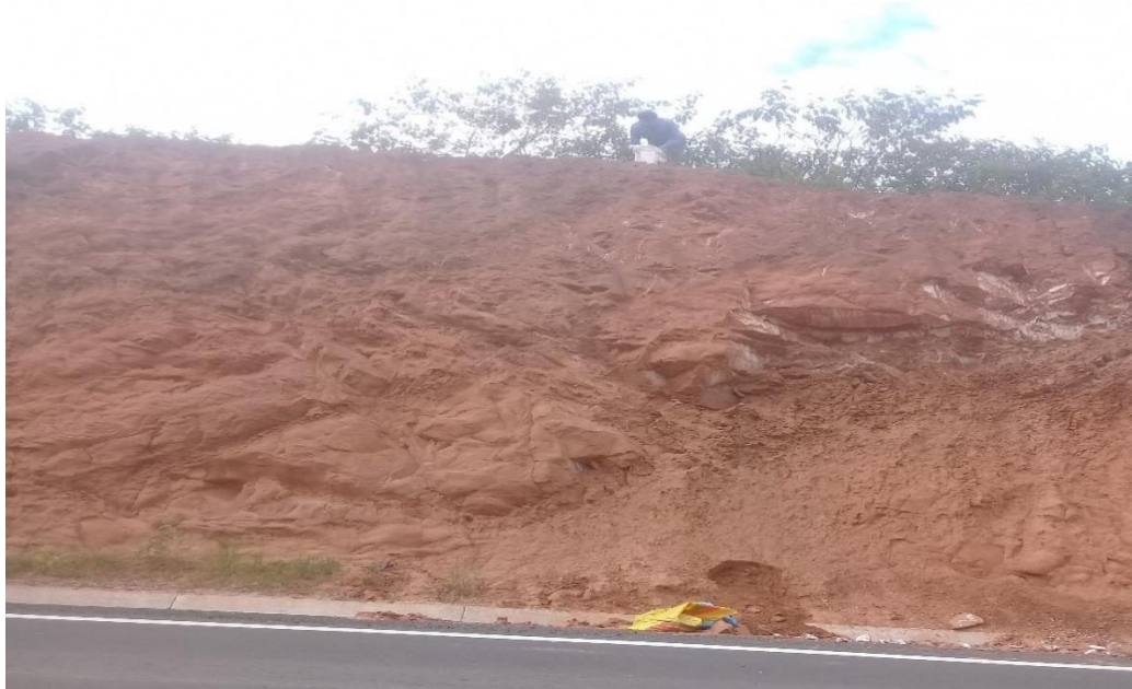
Figura: Extracción de suelo de la parte de la corona del talud
