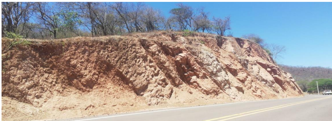
Figura: Vista del talud N° 6
