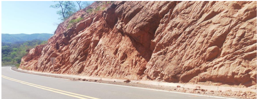
Figura: Vista del talud N° 2
