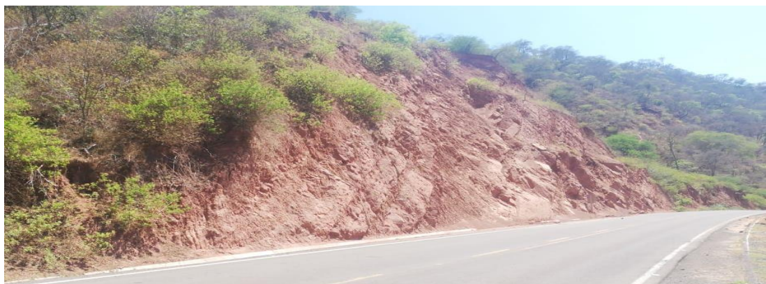
Figura: Vista del talud N° 3
