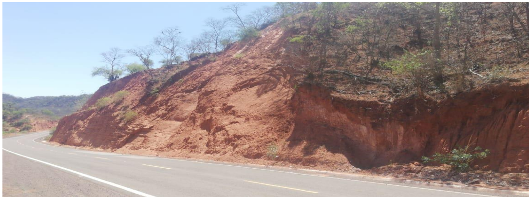
Figura: Vista del talud N° 5
