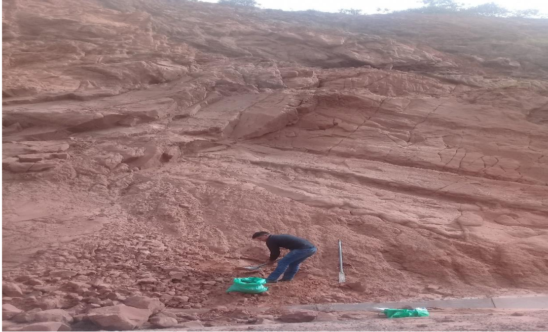
Figura: Extracción de suelo de la parte del pie del talud
