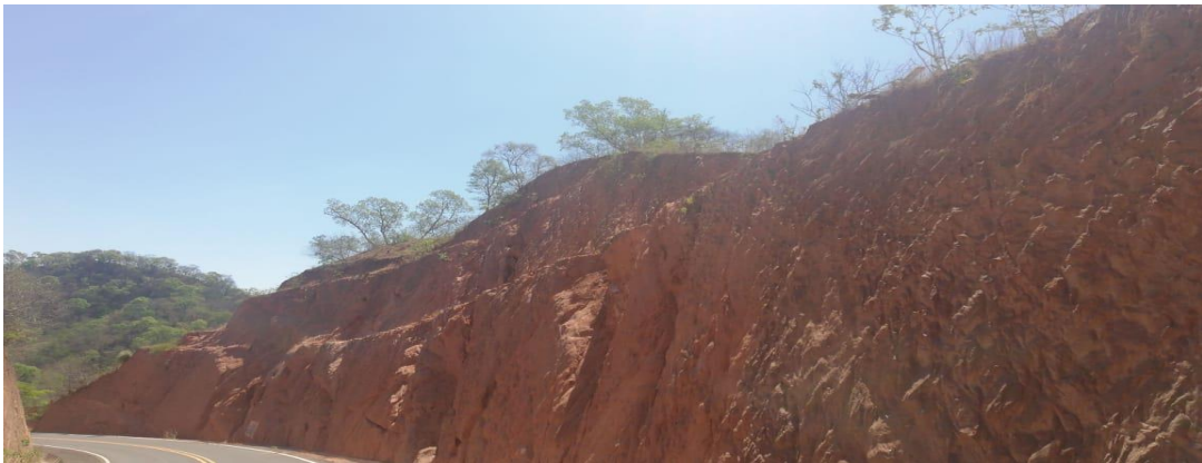
Figura: Vista del talud N° 9
