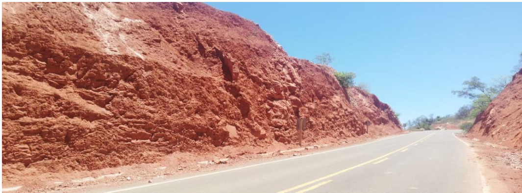
Figura: Vista del talud N° 8
