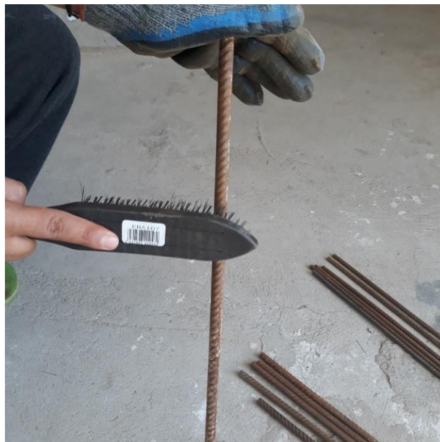
Figura 2. Cepillado de las varillas corroídas
