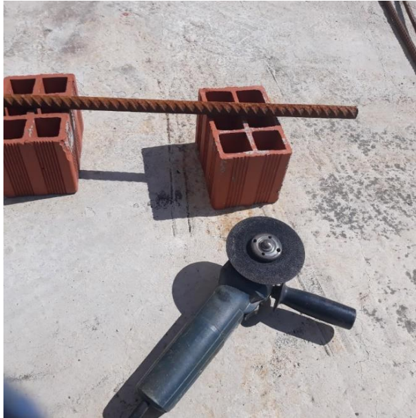
Figura 1. Recorte de varillas según la longitud requerida por la maquina
