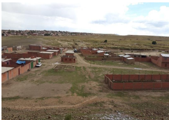
Viviendas sin servicio de Alcantarillado. Sanitario OTB-21.
