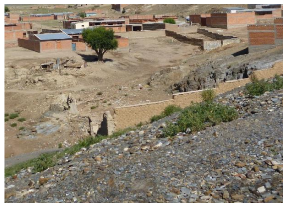
Emplazamiento de la planta de tratamiento de aguas residuales
