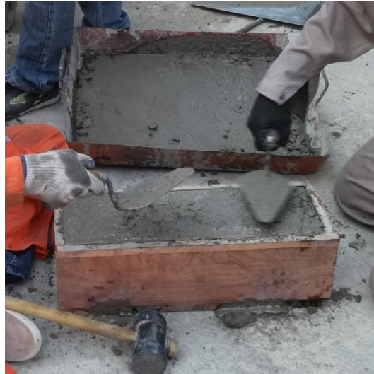
Elaboración de las vigas
