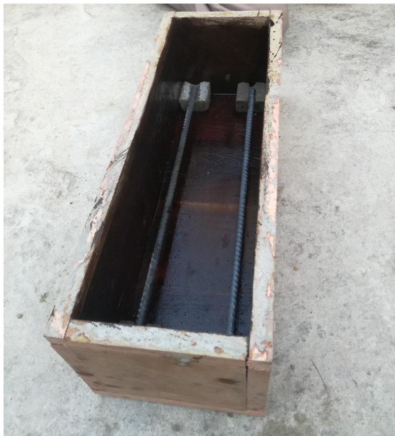
Colocación de armaduras
