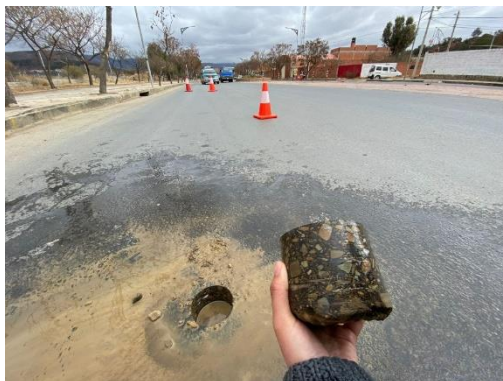
Extracción de la avenida Integración, Espesor promediado 8.95 cms
