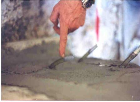
*Figura F.1 Inyectores a la espera de recibir formulación epoxi.*
