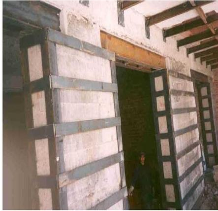
*Figura F.6 Estructuras reforzada con Perfiles Metálicos
