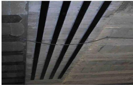
*Figura F7 Viga reforzada con bandas encoladas*
