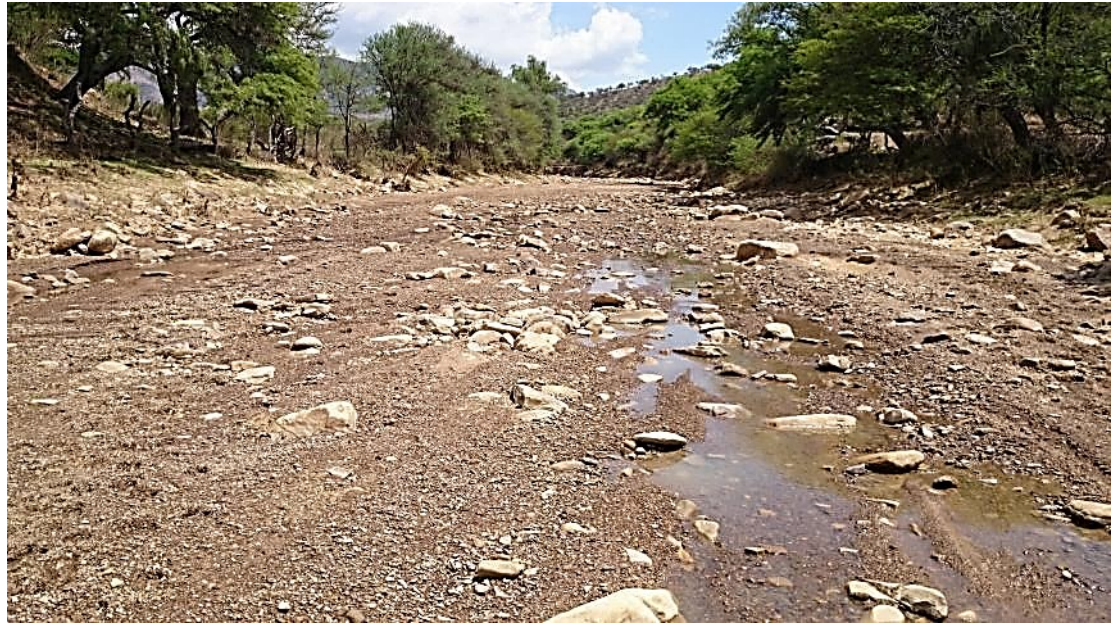
Figura I.5 - Zona de posibles inundaciones en la margen derecha e izquierda. (Progresivas 0+600 a 0+0110, vista de aguas abajo hacia aguas arriba.)
