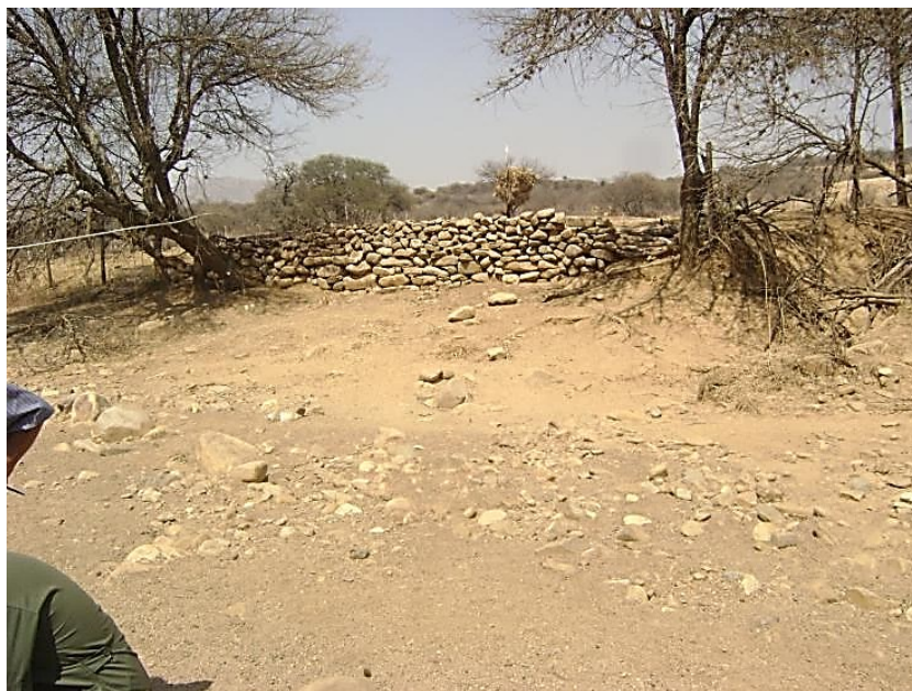
Figura I.7 - Margen derecha de la quebrada de Huayco Grande, en el cual se puede observar la poca altura existente entre el lecho de la quebrada y los terrenos de cultivo.
