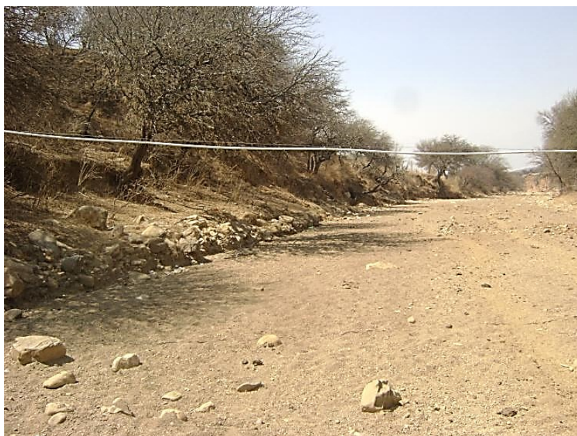
Figura I.8 - Progresiva 0+600, en el cual se puede observar un terreno de pronunciado en la margen izquierda de la quebrada. (Vista de aguas arriba hacia aguas abajo)
