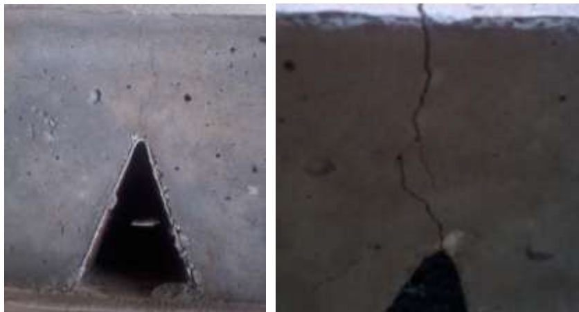
Inductor de fisuras
