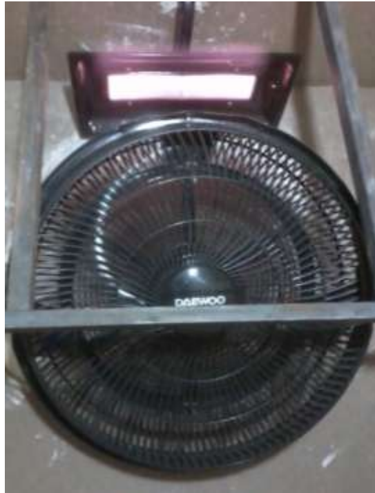
Calentador a gas y ventilador en la cámara ambientada
