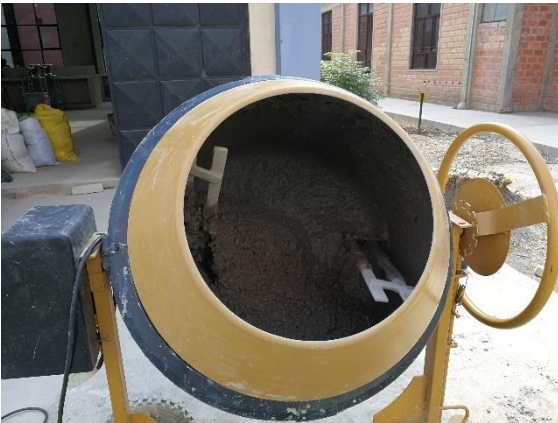
c) Mesclado de los componentes del H°.
