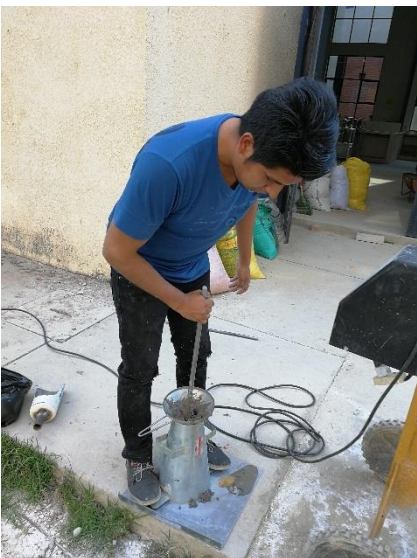
e) Varillado en el cono de Abram.
