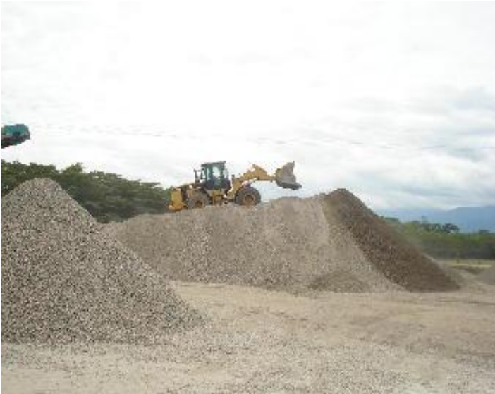
c) Acopio de los agregados mediante maquinaria.
