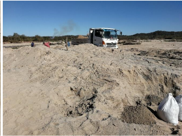
d) Transporte de los agregados.
