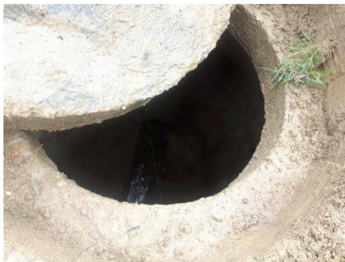
Figura 4. 9. Cámara existente, donde llega una tubería de 8"
