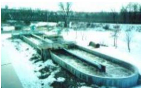
Okotoks WWTP 2.500 m 3 / d Modificación de zanja de oxidación, Ciudad de Okotoks, Alberta, Canadá (Stantec / Aqua MSBR)
