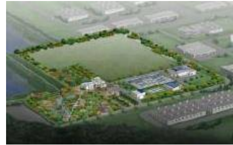
Parque industrial Kunjang BNR WWTP (31.000 m 3 / d), ciudad de Kun San, provincia de ChunBuk, Corea (CSBR)
