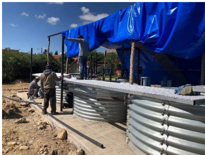
Figura 4. 24. Instalación general de tuberías
