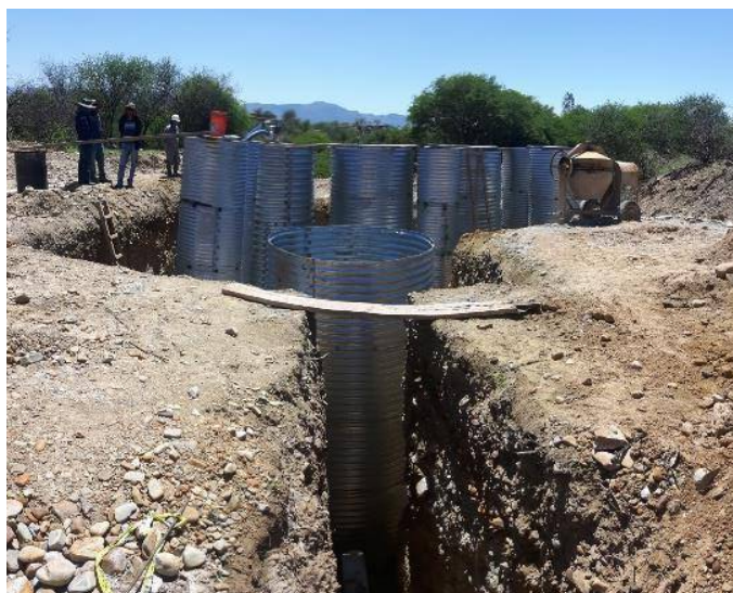
Figura 4. 8. Finalización de la instalación de los tanques
