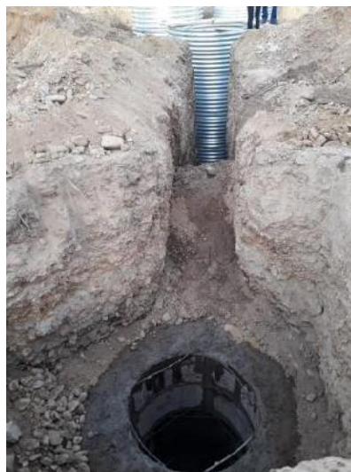
Figura 4. 11. Nueva cámara hacia la planta de demostración de tratamiento de aguas residuales
