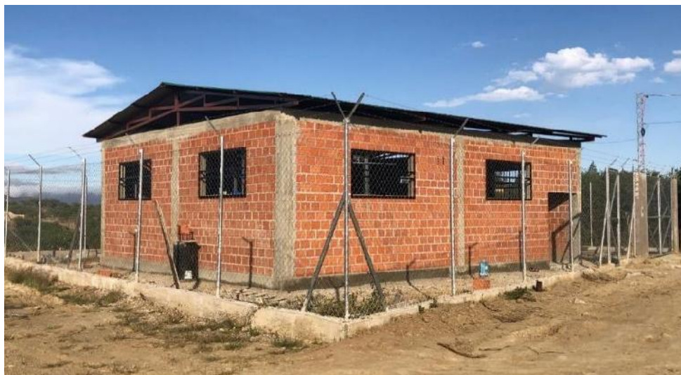
Figura 4. 30. Colocación de cubierta
