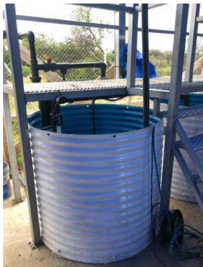
Figura 4. 35. Tanque Anóxico
