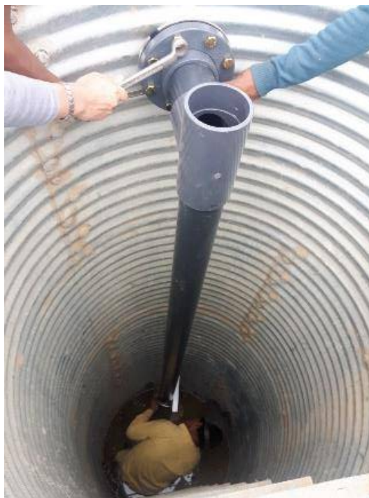
Figura 4. 21. Conexión de las tuberías con bridas en los empalmes
