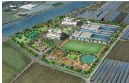
Goyang BNR WWTP (Fase I 80.000 m 3 / d, Fase II 120.000 m 3 / d), Ciudad de Go Yang, Provincia de Kyung Gee, Corea (CSBR)
