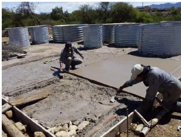
Figura 4. 18. Colocación de losa de concreto con un espesor de 10 cm
