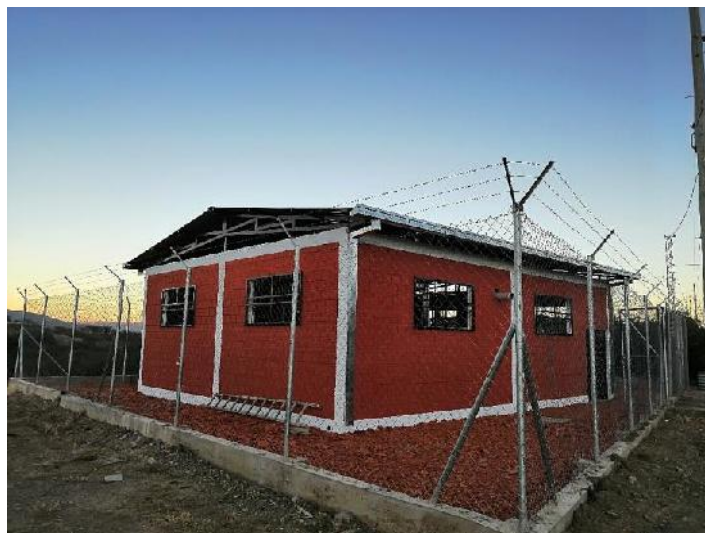
Figura 4. 32. Actualmente la PTAR en su última etapa de construcción finalizada y en espera para poder iniciar la etapa de Puesta en Marcha y Comisionado
