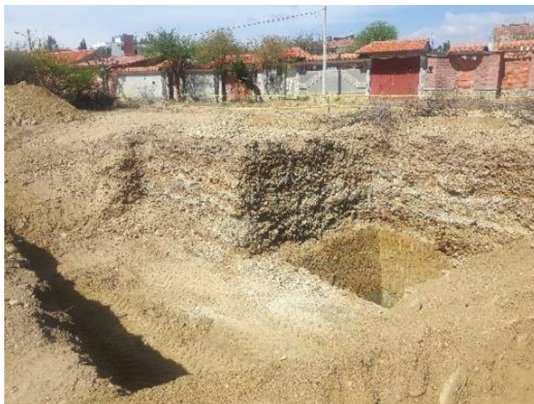
Figura 4. 2. Excavación para la colocación de los tanques a diferentes niveles
