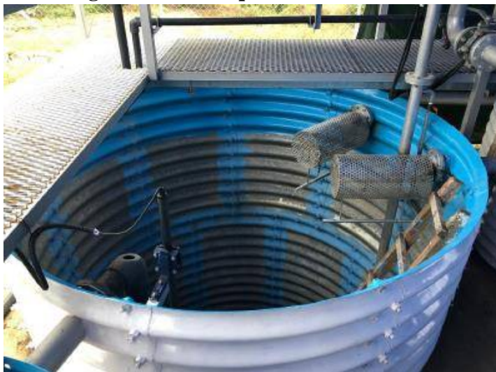
Figura 4. 37. Tanque Aeróbico
