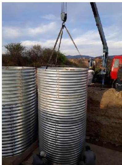
Figura 4. 6. Colocación de los tanques con ayuda de grúa
