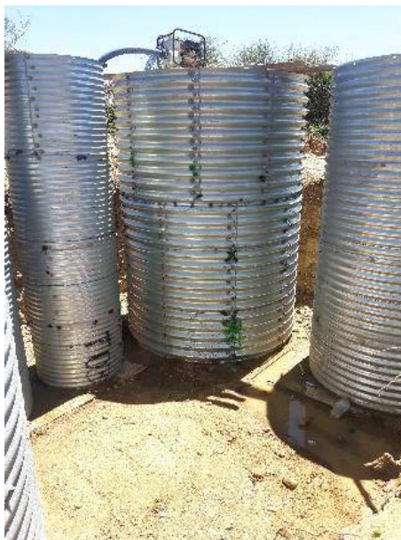
Figura 4. 14. Pruebas de fuga insertando agua y cambiando la misma a los demás tanques mediante bombeo, las fugas se las marcan con un aerosol para la curación correspondiente
