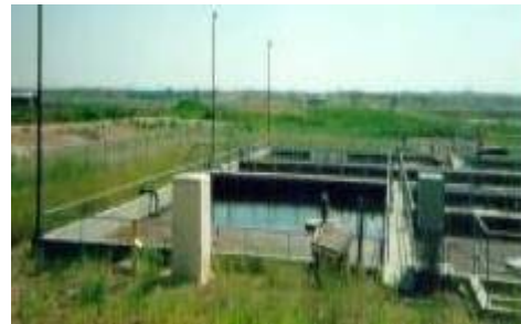
Esteban BNR WWTP (6.000 m 3 / d), Ciudad de Esteban, Saskatchewan, Canadá (Stantec / Aqua MSBR)
