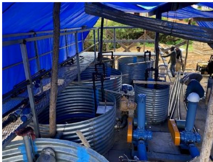
Figura 4. 26. Instalación de andamios, escaleras y pasamos
