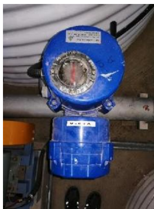
Figura 4. 50. Válvula de Retorno
