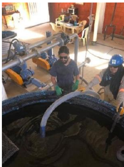
Figura 5. 19. Inserción del lodo en el tanque aeróbico
