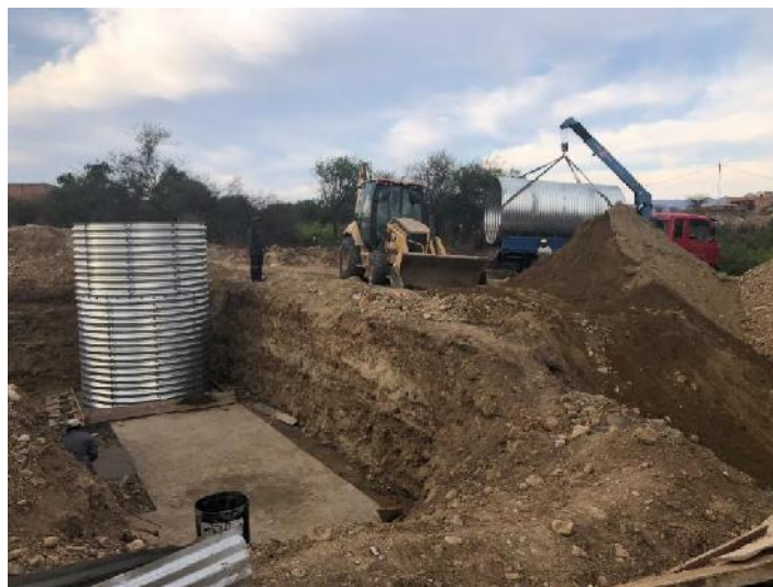
Figura 4. 5. Traslado de los tanques para su respectiva instalación en los cimientos
