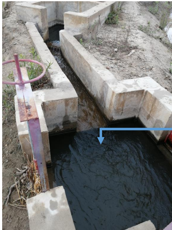
Foto 2 Cámara para el aforo volumétrico
