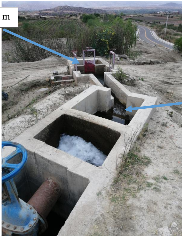
Foto 2 Cámara para el aforo volumétrico
