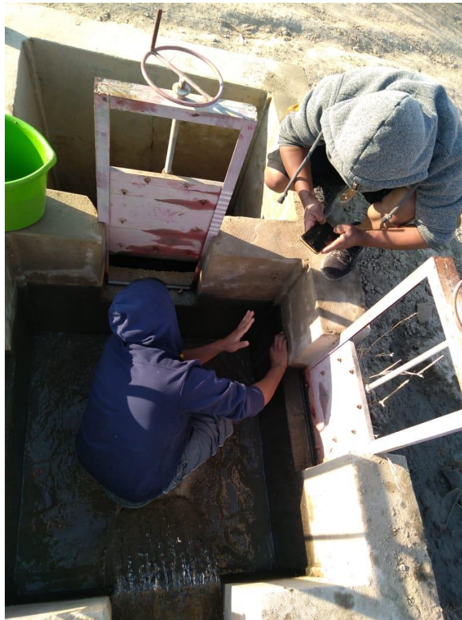
Foto 4 Inicio del aforo volumétrico con un regla milimetrada
