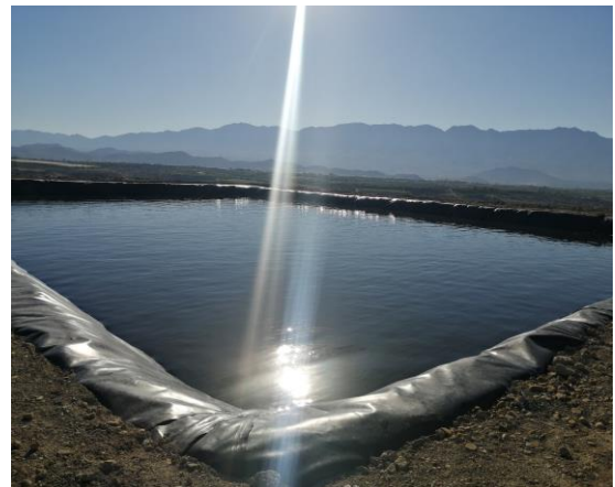
Foto 8 Proceso en marcha del reservorio
