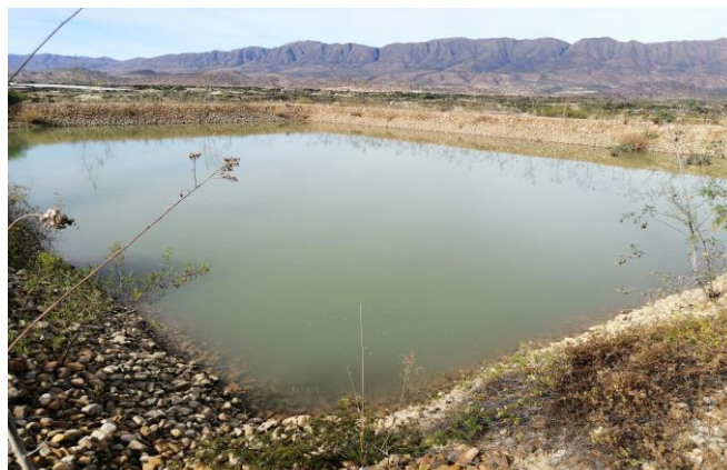
Foto 5 Reservorio antes de la impermeabilización
