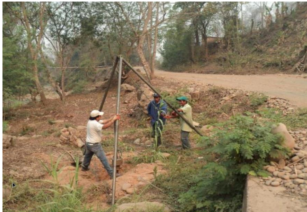
Fotografía 6.- Realización de ensayo in situ SPT.
