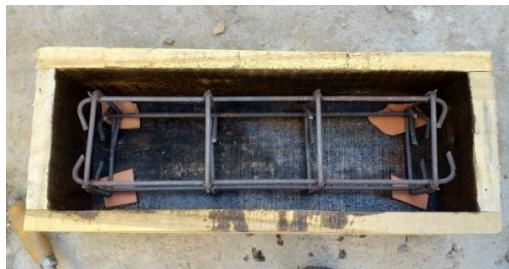
Anexo 10 Armadura de acero corrugado
