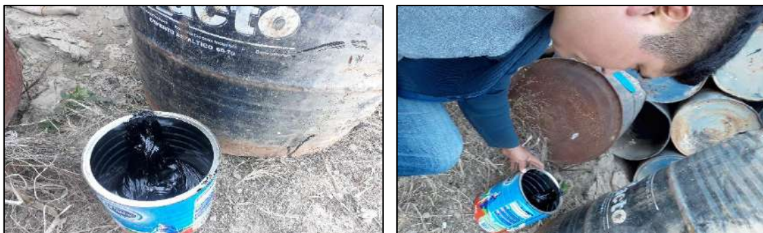
Figura 4: Recolección del cemento asfáltico Petroperú 60 – 70 Pen
