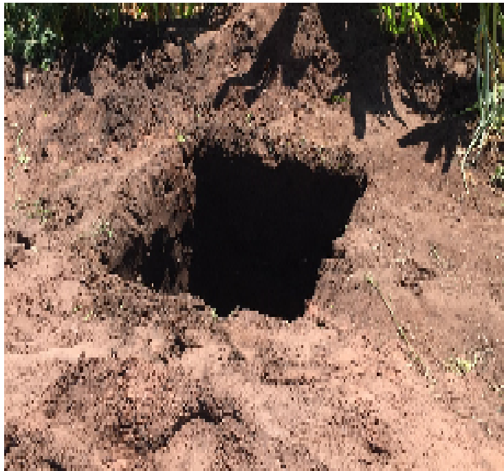
Excavación a cielo abierto POZO 1 a 4 metros.
