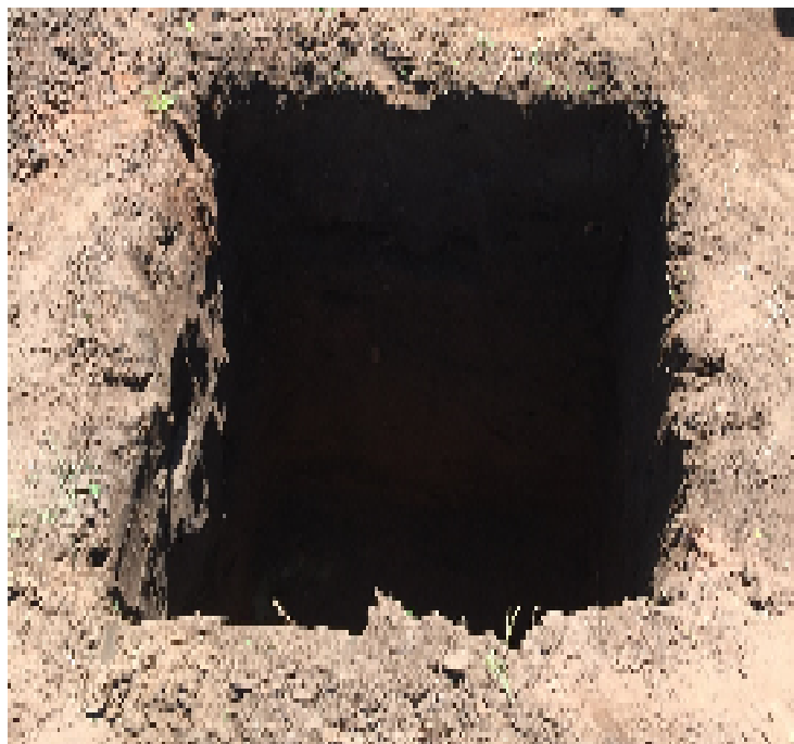
Excavación a cielo abierto POZO 2 a 4 metros
