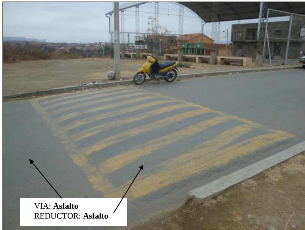
FIGURA 4.5.- Materiales encontrados en la construcción de Vías y Reductores.
