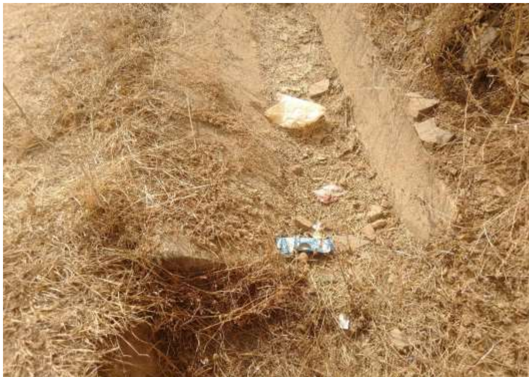
Inicio de cuneta de concreto Progresiva 5 + 210
