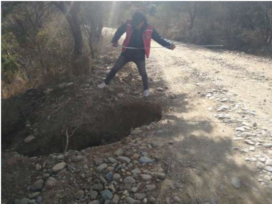
Deterioro del suelo a causa de drenaje inadecuado
