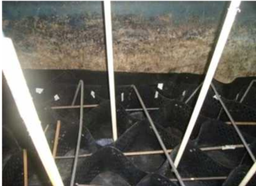
Fotografía 0.8 Montajes de las geoceldas
