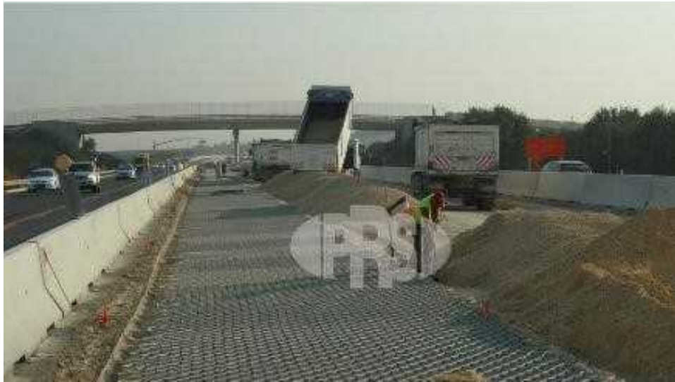
Figura 0.23 Utilización sistema de geoceldas autopista Polonia S7
