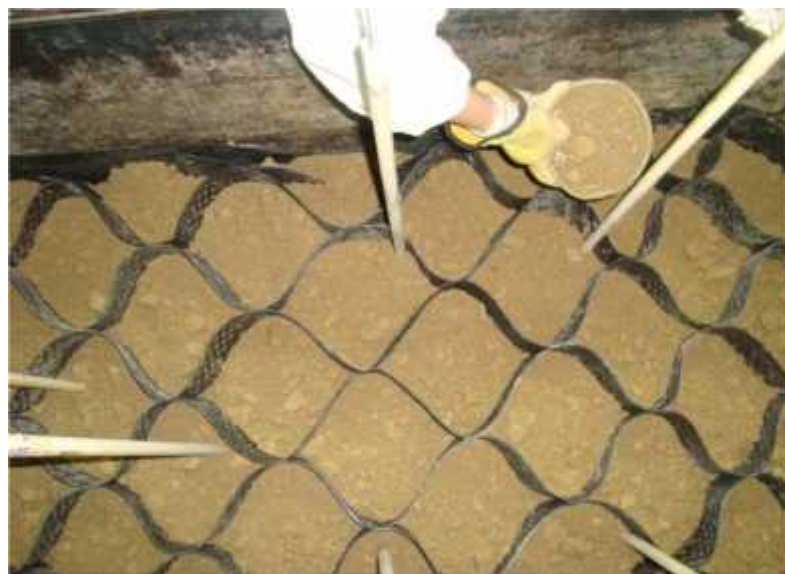
Fotografía 0.9 Geoceldas con material de relleno
