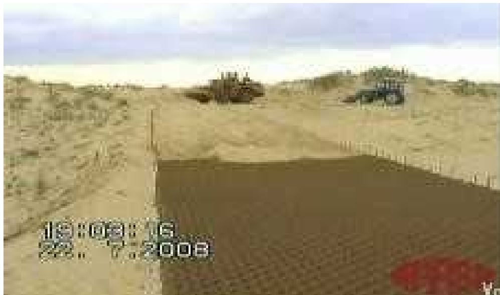
Figura 0.24 Utilización sistema de geoceldas en el desierto de Kazakhstan
