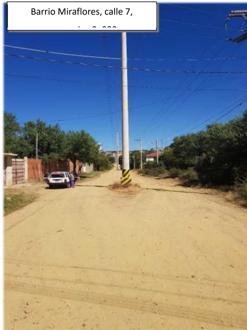
Fotografía 0.1 Progresiva 0+000 de la calle 7 del barrio Miraflores
