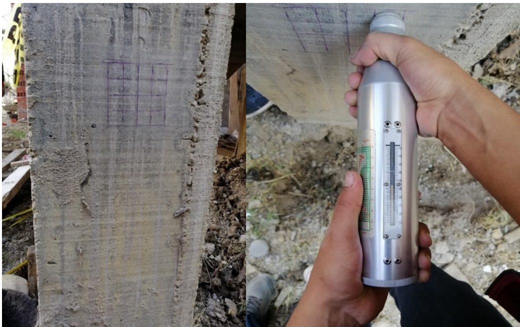
Figura 16. Ensayo de esclerometría en columnas del lab. de farmacología UAJMS
