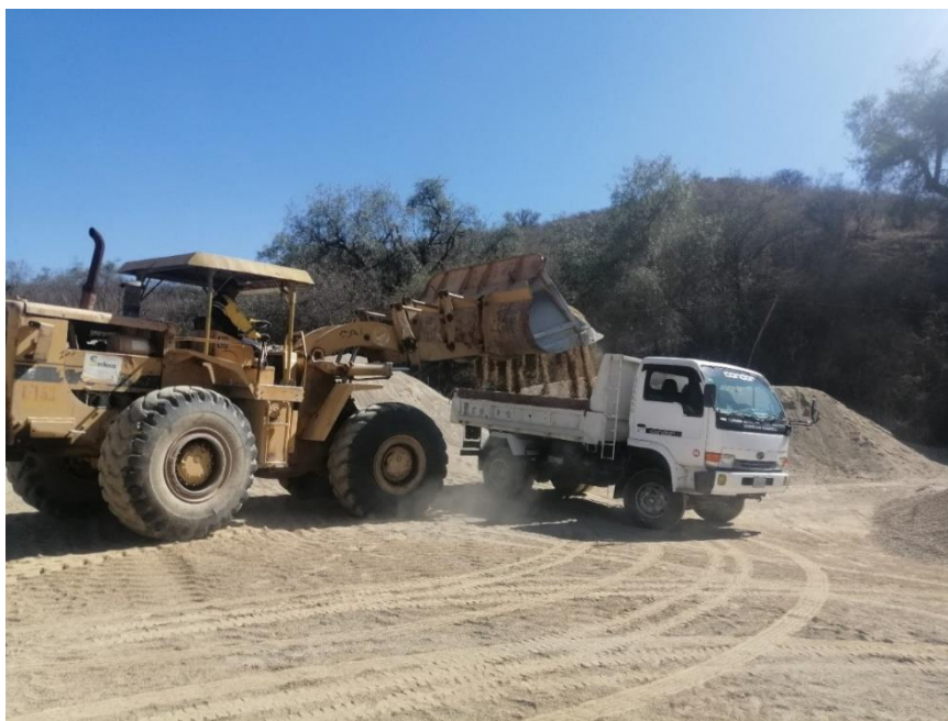
Figura 1. Extracción del material
