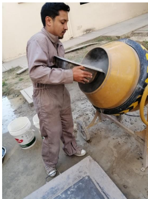
Figura 6. Preparación de la mezcla en la hormigonera
