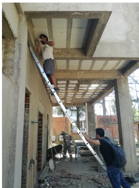
Figura 17. Ensayo de esclerometría en vigas del lab. de farmacología UAJMS
