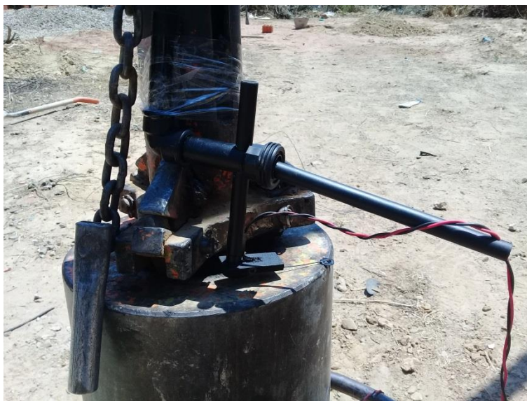
Instalación del interruptor superior conectado al dispositivo.
