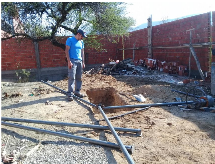
Inspección visual del pozo H, para el armado de SPT.
