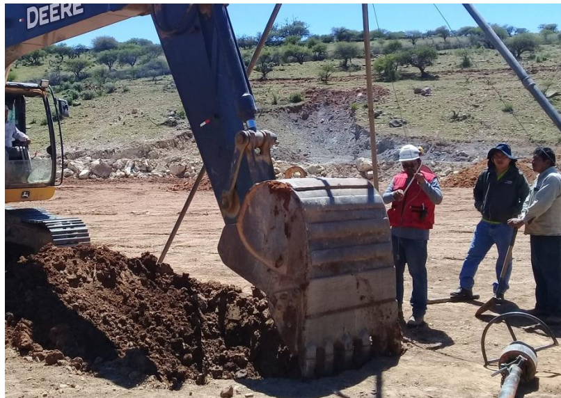
Excavación del pozo A, para la profundidad de 1 m.
