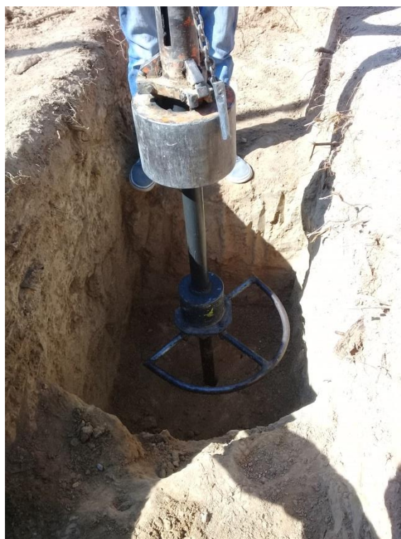
Ejecución del ensayo SPT, haciendo registro del número de golpes.
