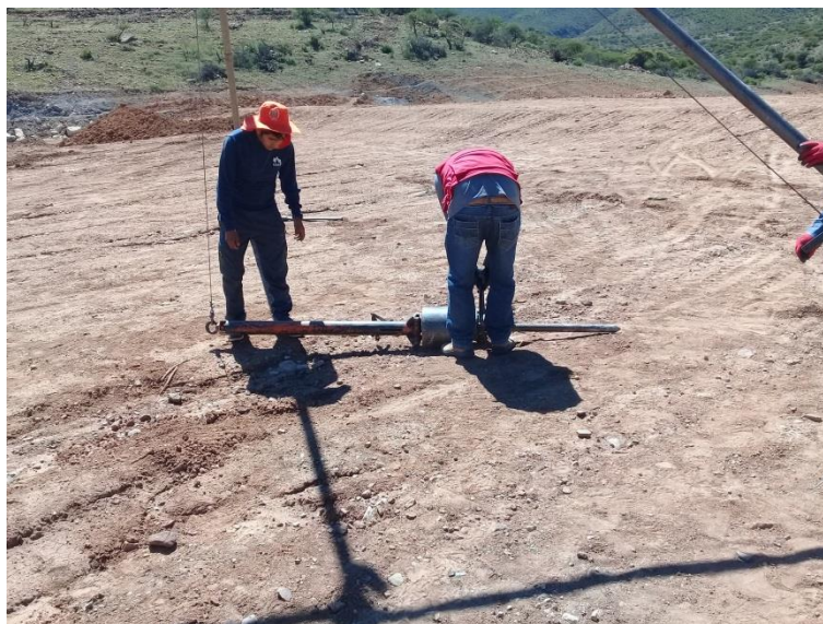
Preparación del equipo de SPT y del trípode, área 1.
