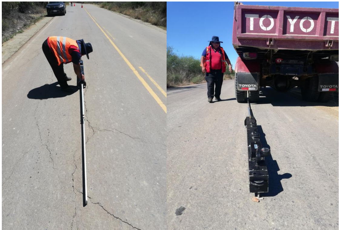
Preparacion del equipo.
