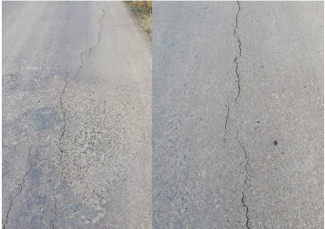
Fisuras longitudinales.
