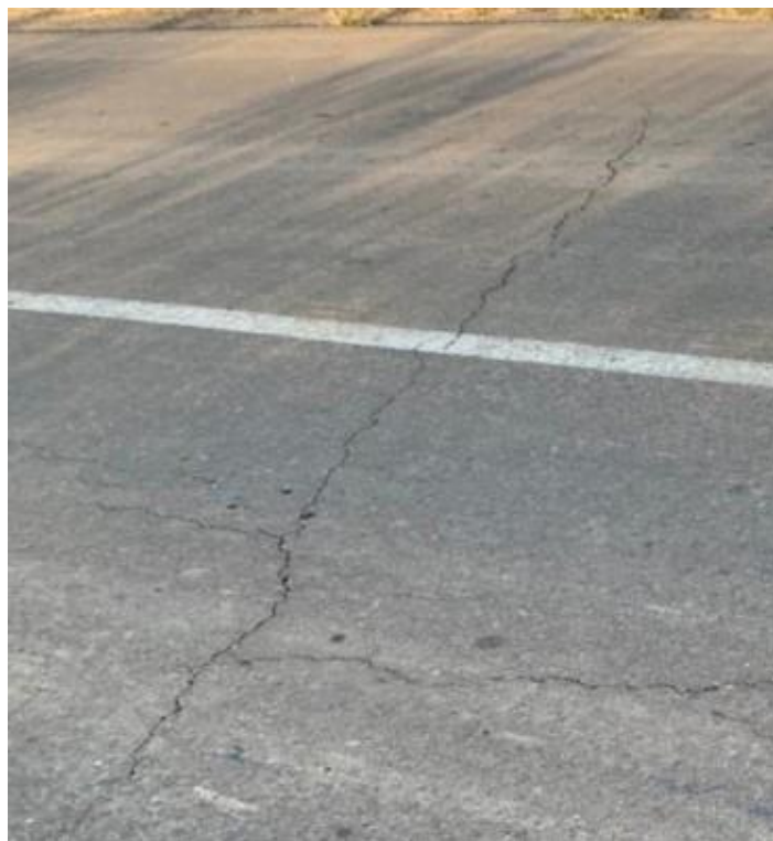
Fisura transversal.
