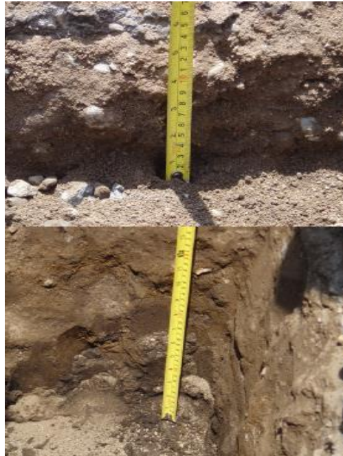
Figura 1. Excavación de la capa base y sub base.
