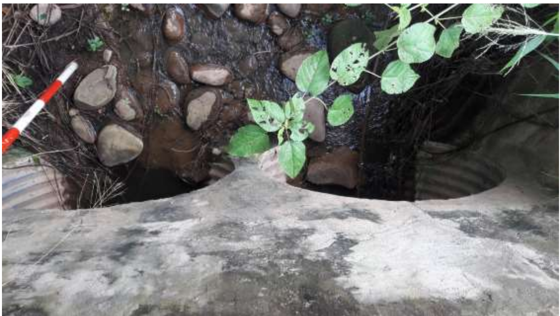
16. Levantamiento topográfico en quebrada, donde hay una alcantarilla de cruce.
