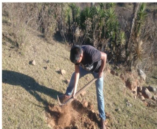
Fotografía N° 15. Excavación apiques a mano Las Lomas
