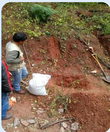
Fotografía N° 13. Excavación apiques manual
