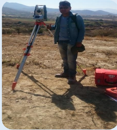
Fotografía N° 9 Levantamiento topográfico lugar Naranjos
